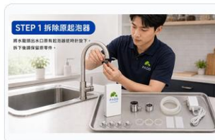
STEP 1 | 拆除原起泡器
